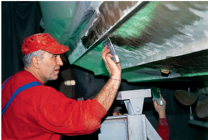
Gegen Osmose hilft nur Schleifen und mit Epoxy spachteln.
